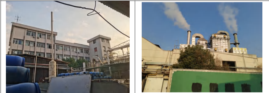
污水站废气处理设施
