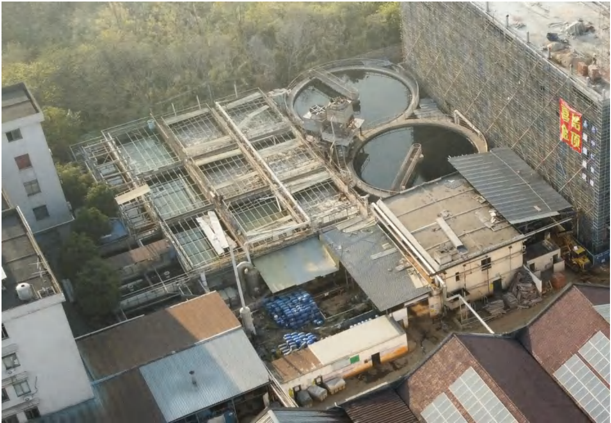
图2.1-7 污水站现场照片
