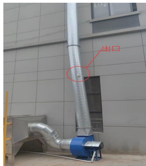
有机废气排气筒进出口采样孔各 1 个
