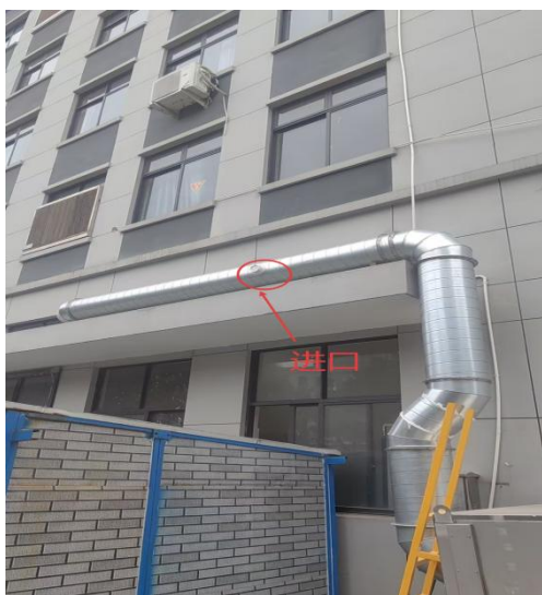
有机废气排气筒进出口采样孔各 1 个
