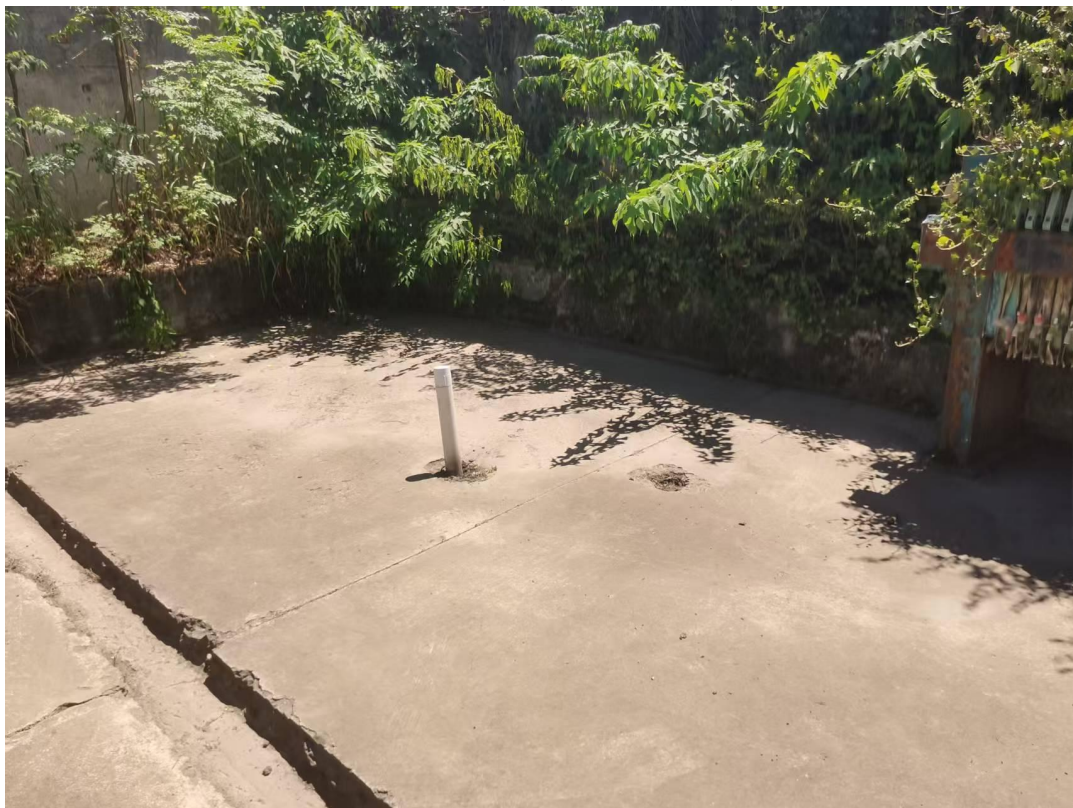
图 2.3-3 厂区内现有地下水环境监测井 BS1 照片
