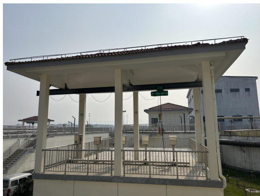
中间提升泵房
