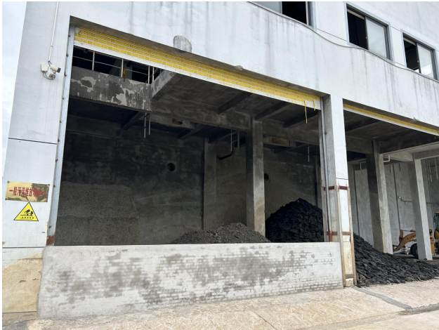
一般固废仓库（二期、三期共用仓库）
