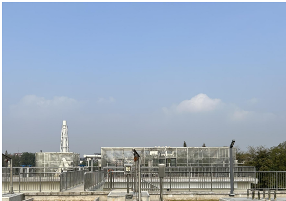
细格栅及曝气沉砂池
