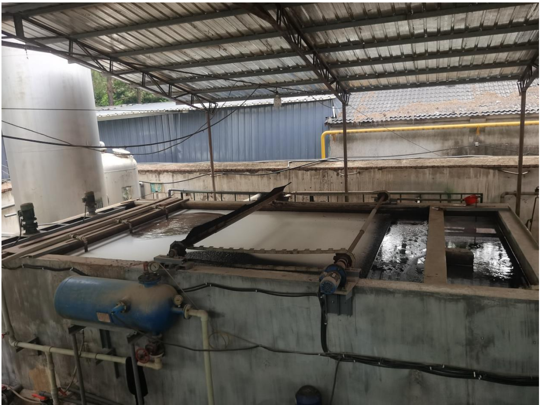
图 4.1.1-4 二沉池（半地下池体，地上高 3m，地下水深 6m）
