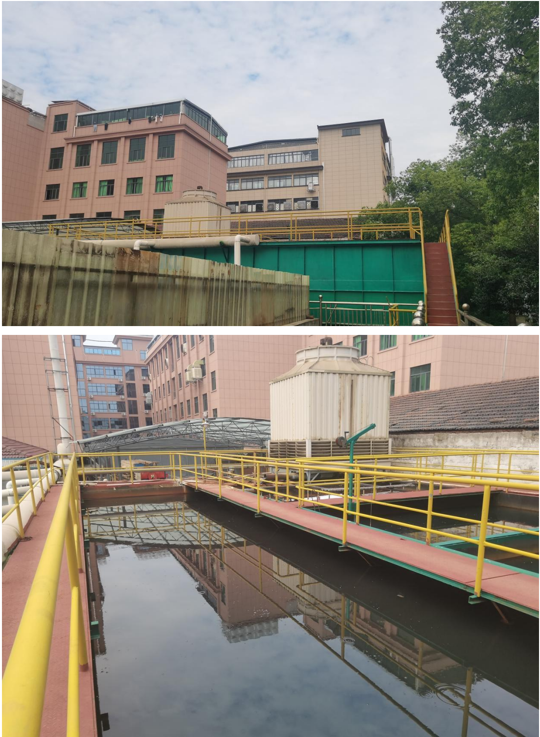
图 4.1.1-2 混凝沉淀池（地上池体，高 6m）
