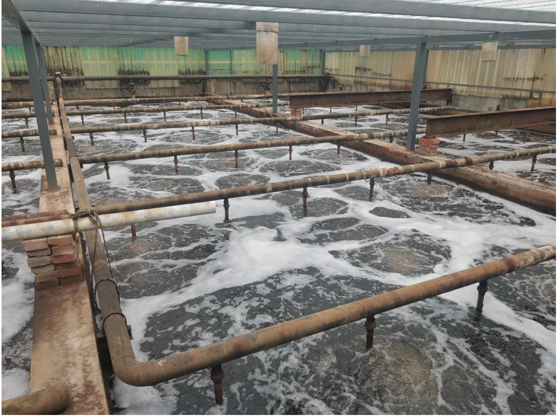
图 4.1.1-3 水解酸化池（半地下池体，地上高 3m，地下水深 6m，加盖）
