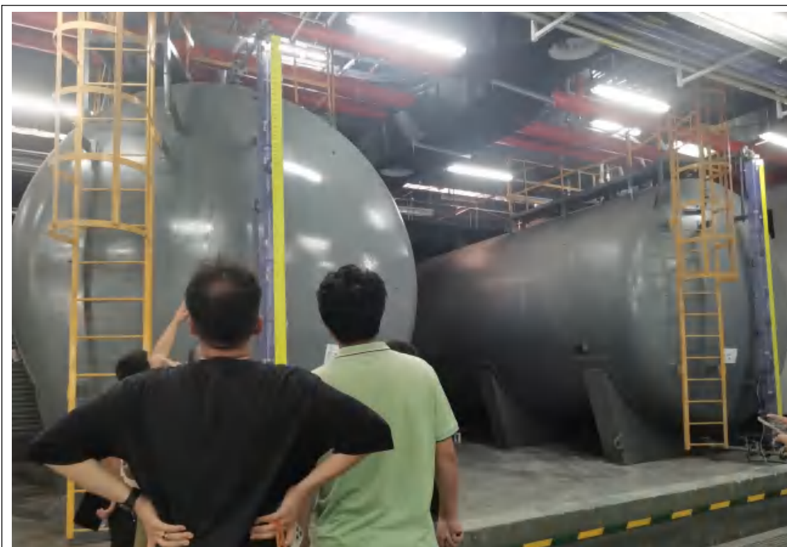
化学品供液间部分罐区
