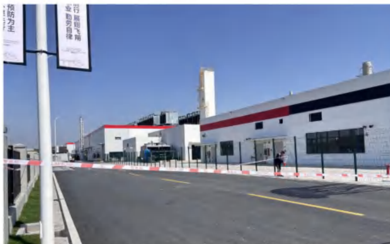
仓库员工 B 立即对泄漏区域进行警戒隔离
