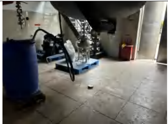
五车间+制剂一车间废水收集池、地漏
