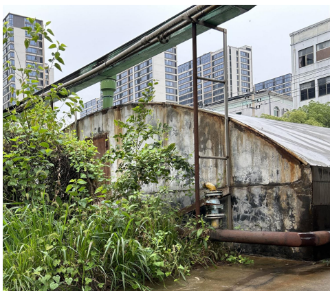
老污水处理站池体照片
