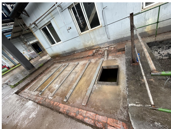
五车间+制剂一车间外收集池照片
