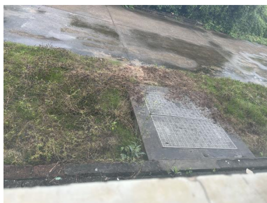
老固废仓库外地下收集井
