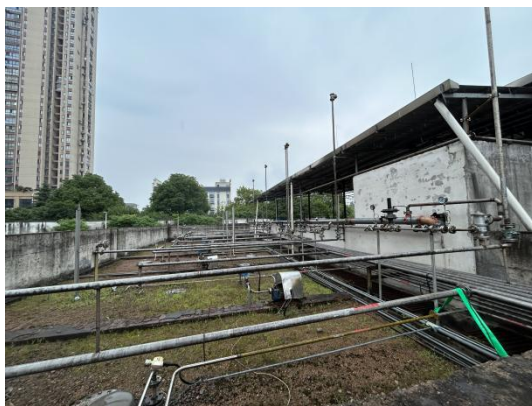
甲类罐区储罐照片
