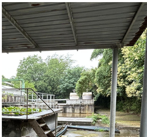
老污水处理站药剂储罐照片
