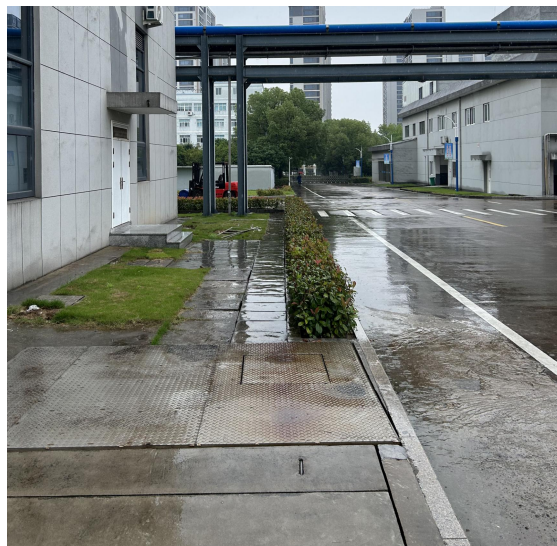
制剂车间外收集池照片
