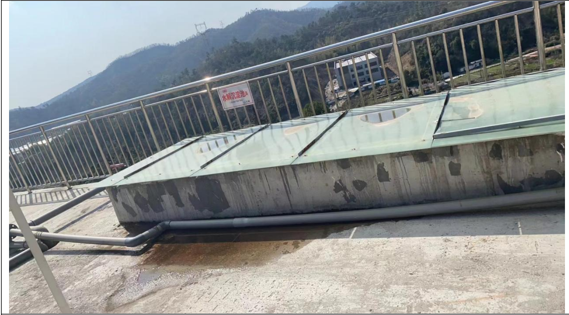
污水站加盖现场照片
