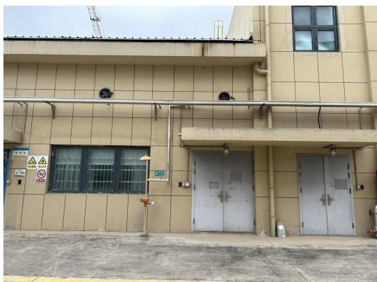
图 2.5-5 8 号乙类化学品仓库有机库洗眼装置及通风装置
