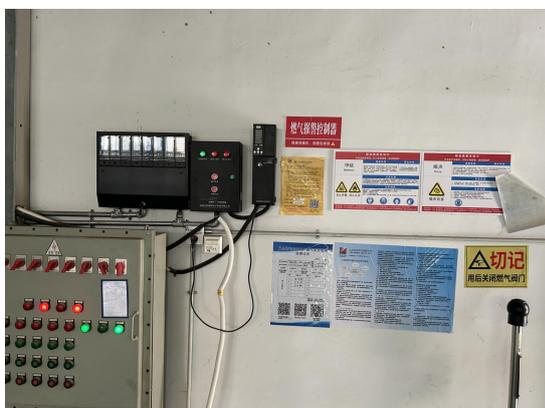
图 2.5-3 6 号纯水站锅炉房可燃气体报警器
