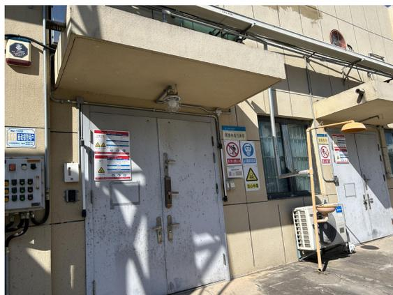
图 2.5-7 10 号化学品仓库双氧水库、腐蚀气体库洗眼装置及通风装置
