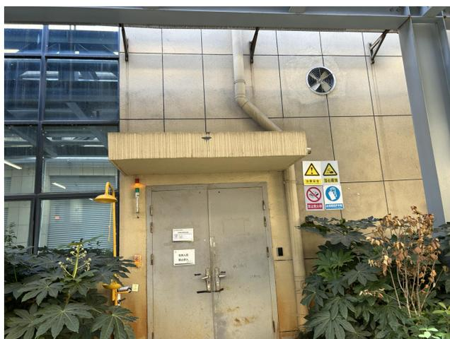
图 2.5-4 无机 CDS 间洗眼装置及通风装置
