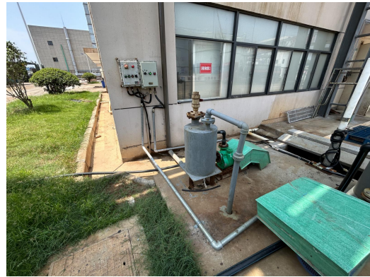
图 4-5 生产车间三离地和地下污水收集池照片
