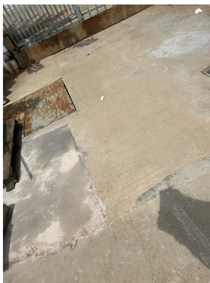
图 4-8 雨水收集池（地下）照片
