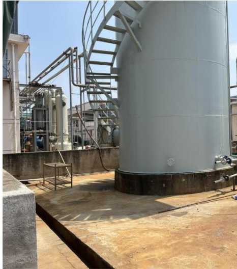
图 4-2 四氯乙烯储罐（储罐区二）照片
