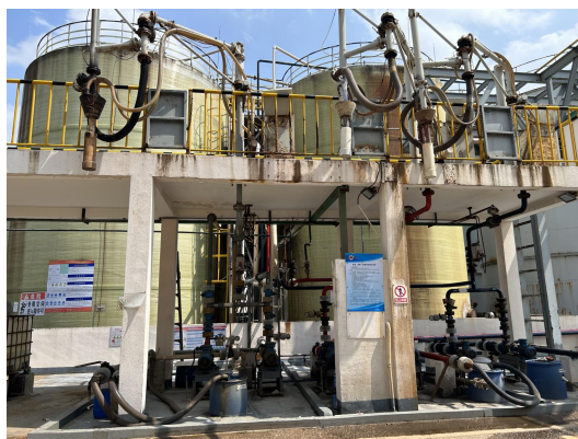
图 4-9 泵区、装卸区照片
