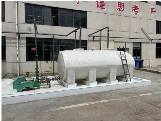
图 4-5 生产车间三离地和地下污水收集池照片
