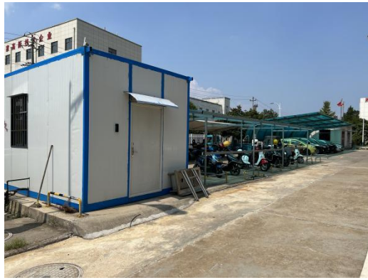
图 4-17 事故应急池（地下）照片
