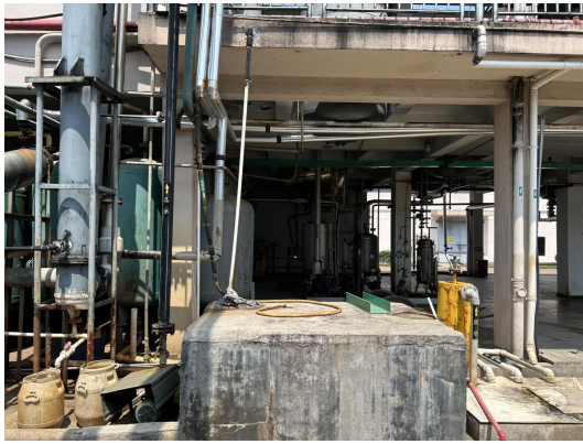
图 4-3 生产车间二半地下污水收集池、地下循环水照片
