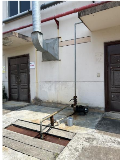
图 4-3 生产车间二半地下污水收集池、地下循环水照片
