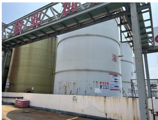
图 4-1 硫酸、盐酸、液碱储罐（储罐区一）照片
