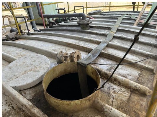
图 4-6 老污水处理站调节池照片
