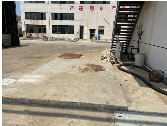
图 4-4 生产车间一地下污水收集池照片
