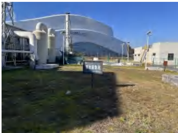
图 4-8 应急池及切换阀
