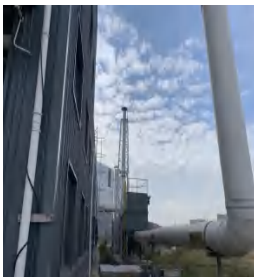
图 4-9 危废暂存间粉尘及恶臭废气处理设施 化验室
