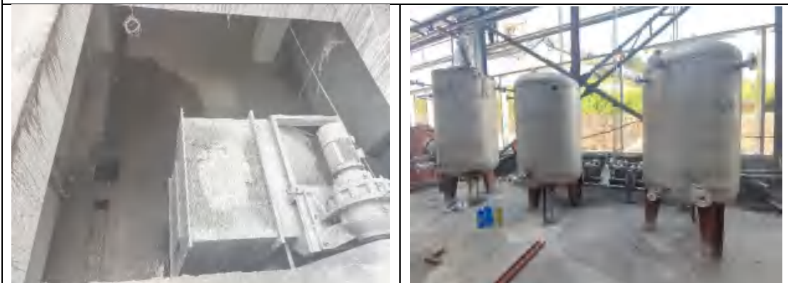
焚烧车间地下一层
