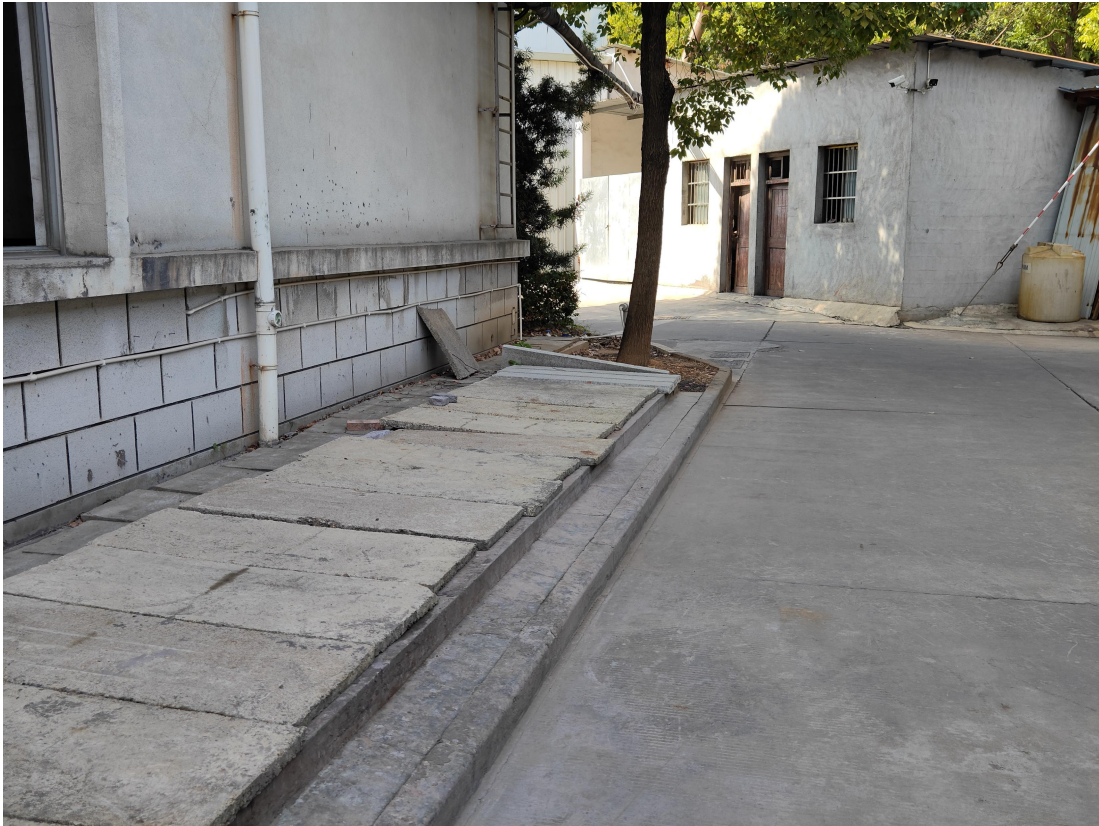
图 4.3-3 车间外沉淀池
