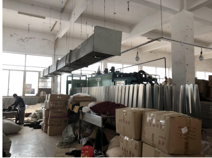
车间防护设施
