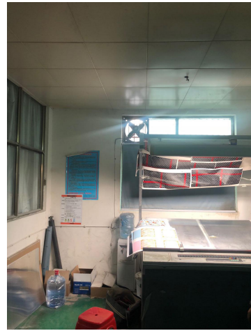
印刷工序防护设施
